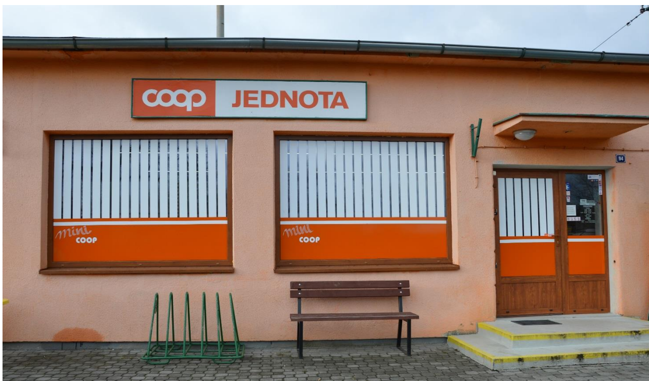
Po zakoupení prodejny obec vyměnila koncem roku 2018 obě výlohy a v únoru 2019 vstupní dveře. V současné době je objednáno zpracování projektové dokumentace na vytápění objektu.
