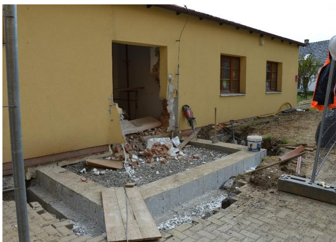
Původní kabinet byl zrušen, začíná přístavba bezbariérového vstupu
